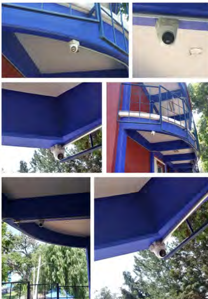
Imagen 7. Instalación de cámaras en edificios de la DICEA.
